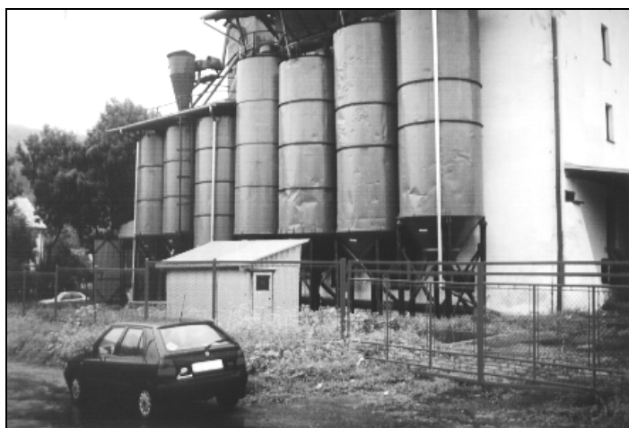
Rys. 1. Silos na zboże ze ścianami zniszczonymi podczas dynamicznego opróżniania Fig. 1. Silos for cereals with walls destroyed during dynamic discharge
